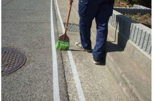
水分・砂・ホコリ等を完全に除去します。(除去が不完全ですとプライマーの性能が低下します)
