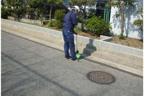
水分・砂・ホコリ等を完全に除去します。(除去が不完全ですと目地シールの性能が低下します)
