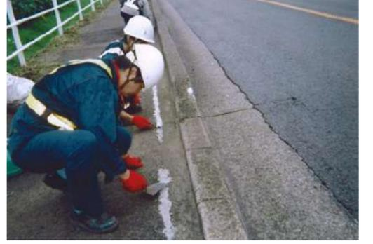
除草・抜根後の目地穴を、モルタル等で充填します。
