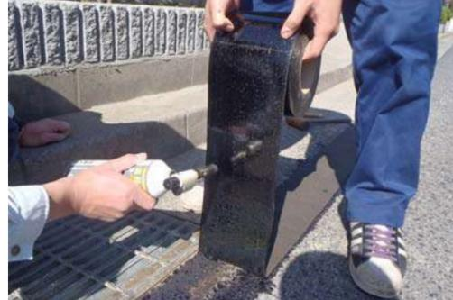
トーチにて均一に炙りながら接着します。(貼り直しは目地シールの性能が低下します)
