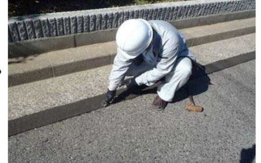
炙って裏面が溶けているうちに、靴底やローラーなどで転圧をし、確実に密着させます。
