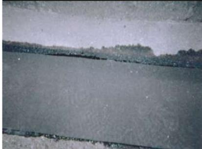
下層の改質アスファルトが溶けて端部から少しはみ出る程度が目安です。
