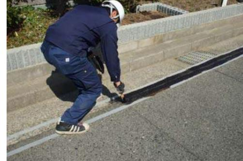
厚塗り・薄塗りに注意し、均一に専用プライマーを塗布します。
