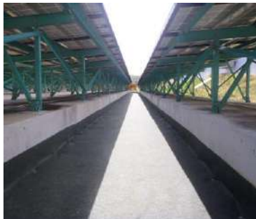
コンクリート製架台と接着
