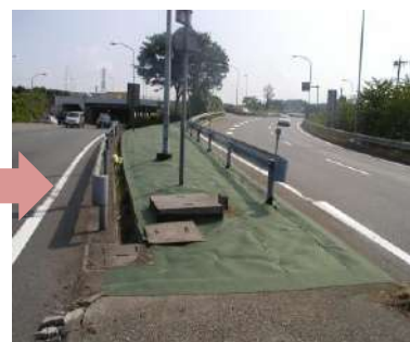
施工後 マット同士・マットとU字溝 マットと縁石を接着
