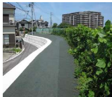
擁壁との接着
