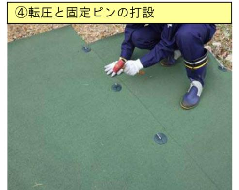
④転圧と固定ピンの打設
