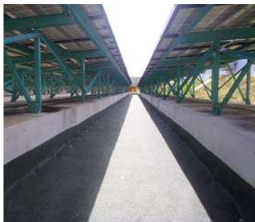
コンクリート製架台と接着
