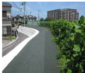
擁壁との接着
