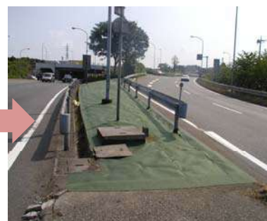
施工後 マット同士・マットとU字溝 マットと縁石を接着
