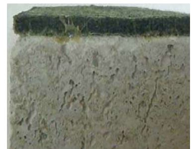
シート（マット）とコンクリート との接着
