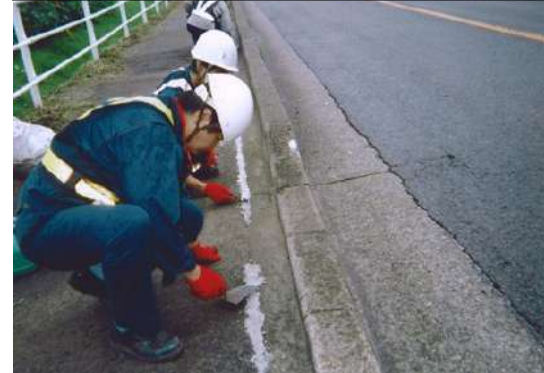
③ 目地穴モルタル充填
