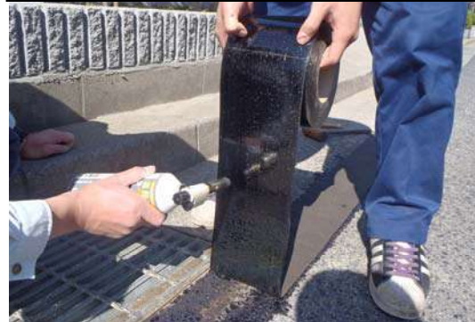
⑪ 目地シール貼り付け (トーチ使用)
