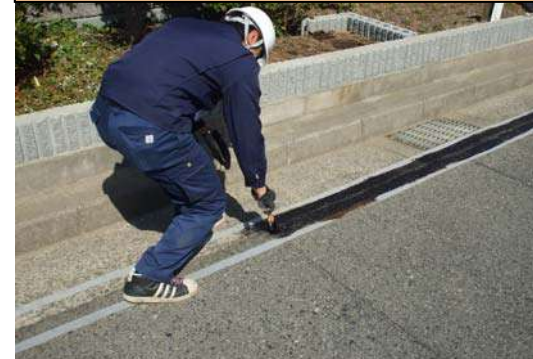
⑧ 専用プライマー塗布
