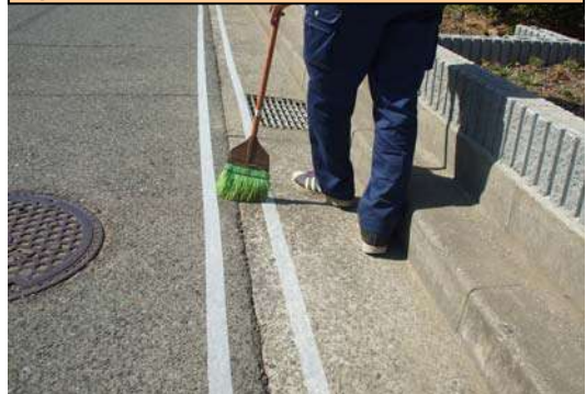
⑦ プライマー塗布面の清掃
