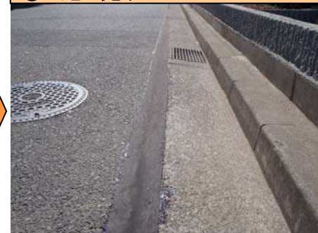
⑯ 施工完了
