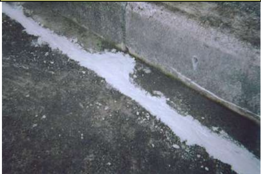
④ ヒビ割れモルタル補修
