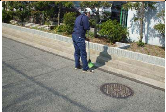
⑩ 目地シール貼り付け面の清掃
