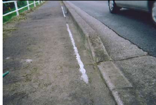
⑤ 目地穴補修完成
