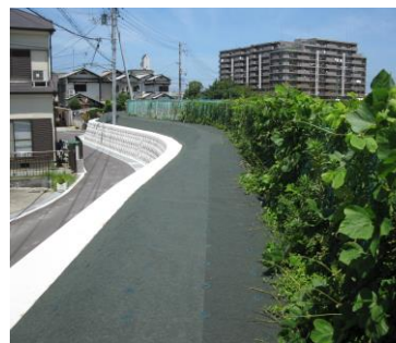
擁壁との接着
