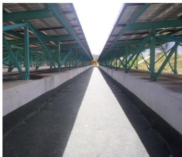
コンクリート製架台と接着
